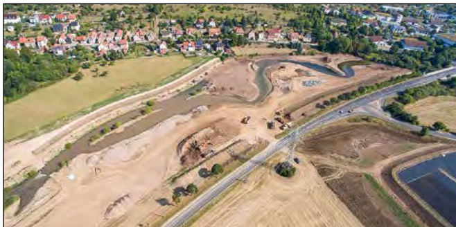
Bau der Hörsel-Renaturierung Stedtfeld Foto: Geodienst Ralf Schuhmann, 2016
