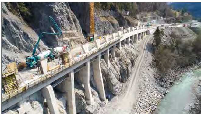
L 76 Landecker Straße, Neubau Schlossgalerie, aktuell ausgeführte Steinschlagschutzbauten
