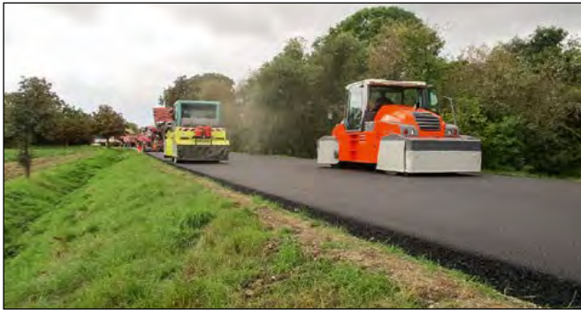
Abbildung 8: Gummiradwalzen drücken mit mehreren Überrollungen den Asphalt an Quelle: TLBV
