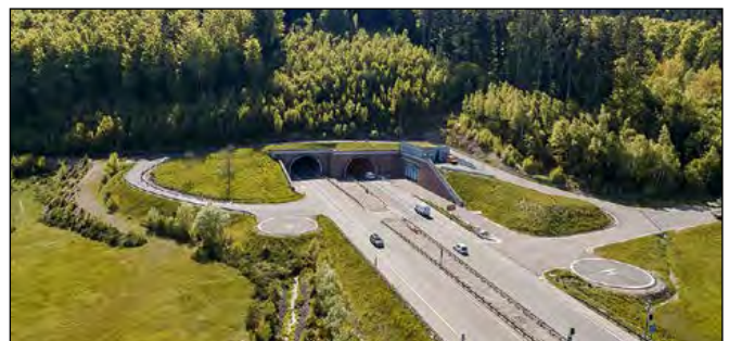
Abb. 2: Nordportal Tunnel Rennsteig mit Havarie-ZBL
