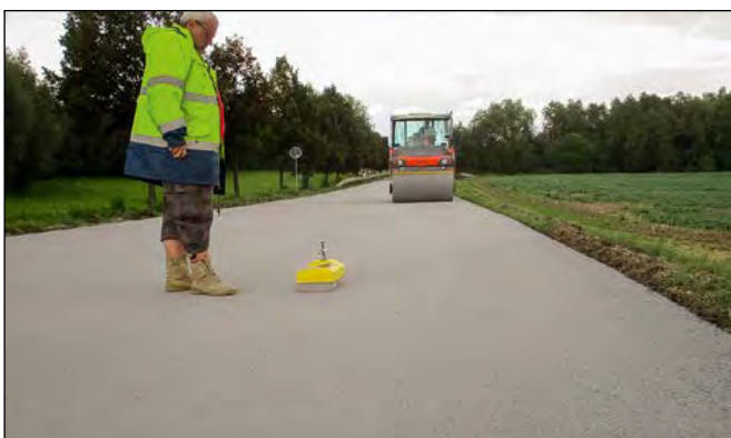
Abbildung 10: Die Verdichtungsleistung wurde während des gesamten Fertigungsprozesses fortlaufend mittels Isotropensonde kontrolliert Quelle: TLBV
