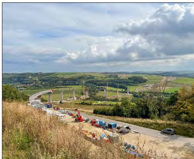
Saaletalquerung der B 87n im Bau
