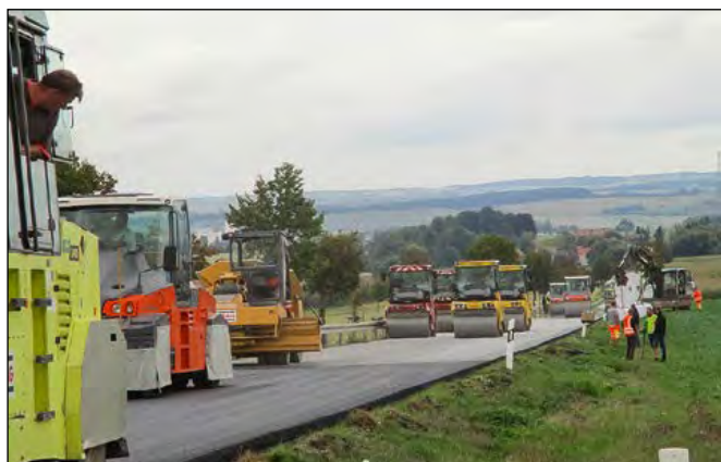
Abbildung 1: Einbau des Hochverdichtungsasphaltes an der B 84 zwischen Allmenhausen und Billeben Quelle: TLBV
