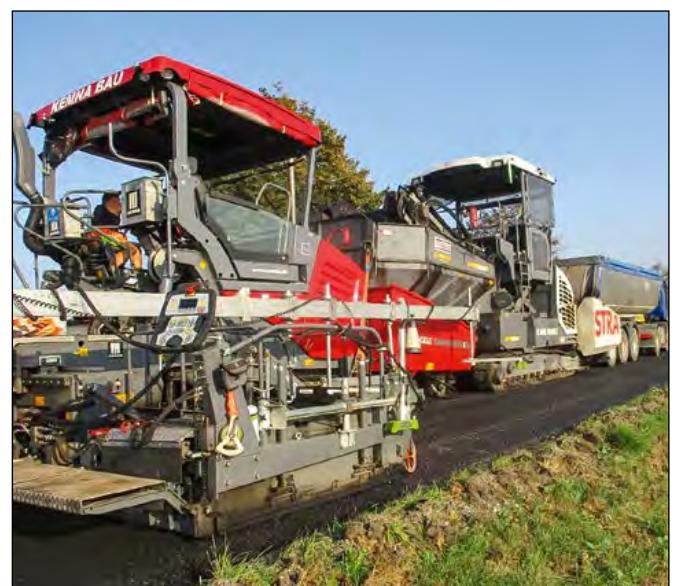
Abbildung 7: Einbau des Asphaltes über die volle Fahrbahnbreite der B 84 mit Beschicker und Fertiger Quelle: TLBV
