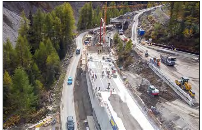
B 186 Ötztalstraße, Lückenschluss Leck-/Klammgalerie, aktuell ausgeführte Mur- und Steinschlagschutzbauten
