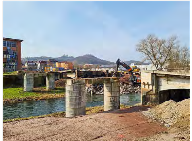
Abbruch Brücke Friedrich-Naumann-Straße Foto: A. Jaszbereny
