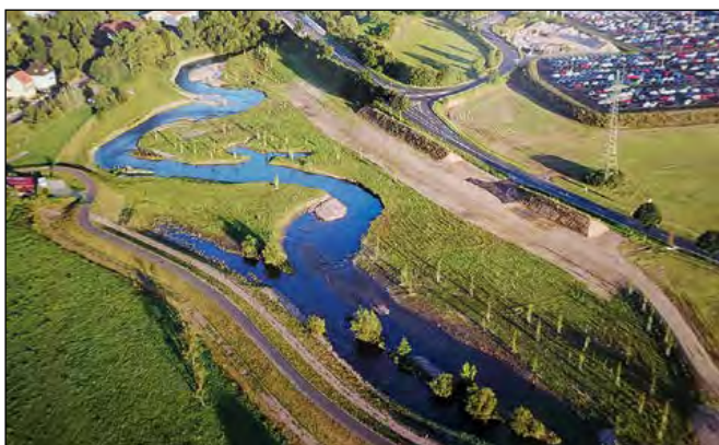
Hörsel-Renaturierung nach Fertigstellung Foto: M. Rauschenberg, 01.09.2017
