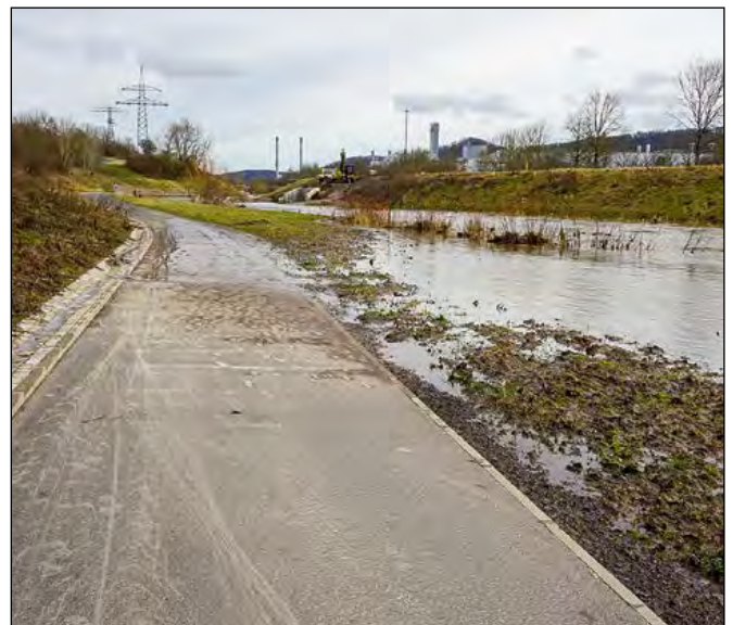
Neu gebauter gewässernaher Radweg entlang der Hörsel Foto: B. Schumann, 10.02.2024)
