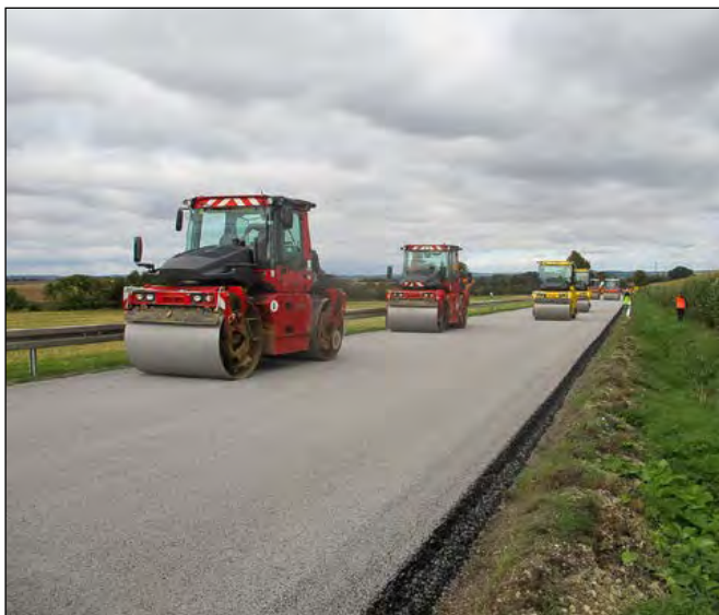
Abbildung 3: Impressionen von der Verdichtungsarbeit der Walzen Quelle: TLBV
