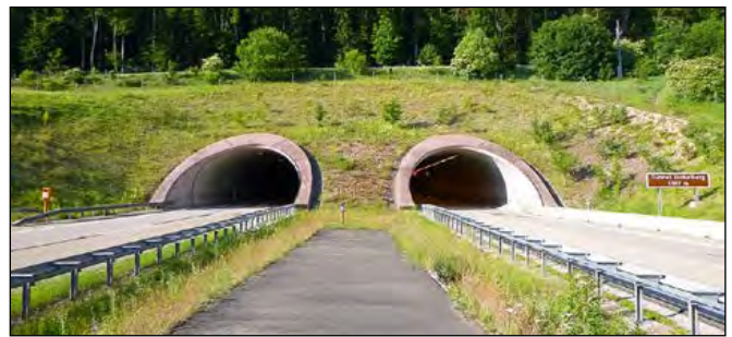
Abb. 1: Tunnel Eichelberg Quelle: Die Autobahn GmbH des Bundes
