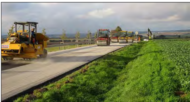
Abbildung 9: Die Abstreuerung des Asphalttes erfolgte mit einem selbstfahrenden Linienstreuer Quelle: TLBV
