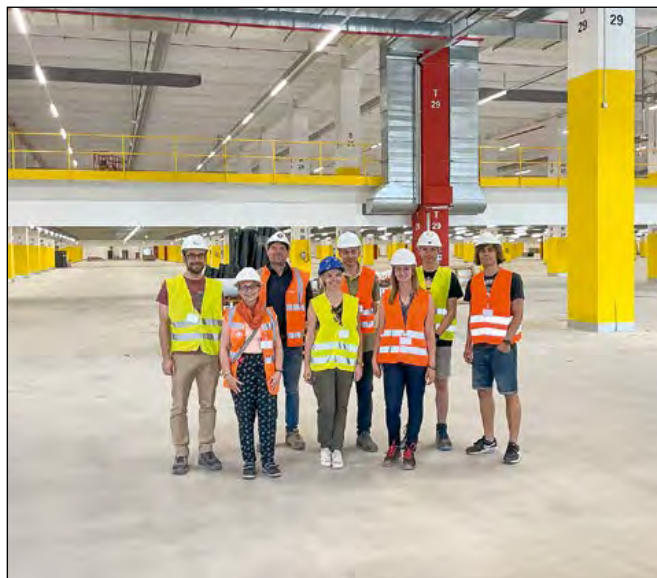
Rohbau Amazon-Logistikzentrum Erfurt-Stotternheim
