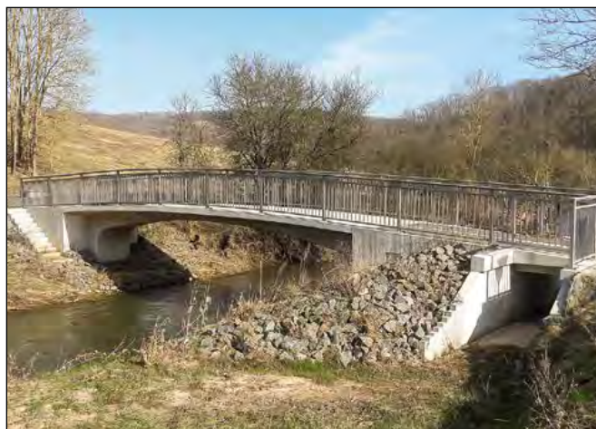
Neue Radwegbrücke zwischen Seega und Günserode
