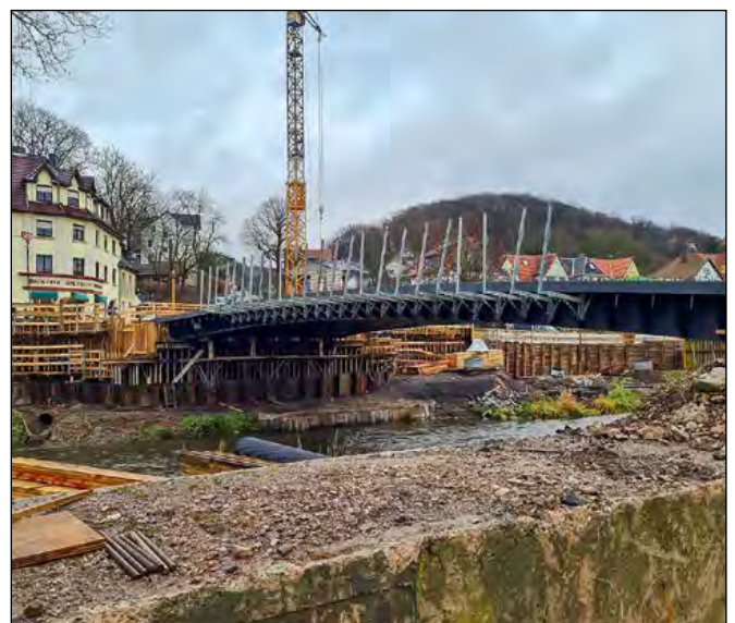
Brücke Friedrich-Naumann-Straße im Bau Foto: A. Jaszbereny
